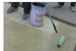
長毛ローラー使用して塗る
