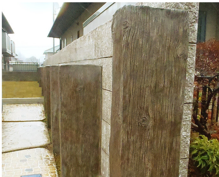
ブロック塀（ビジャンスレート）、控え壁（ビンテージウッド）
