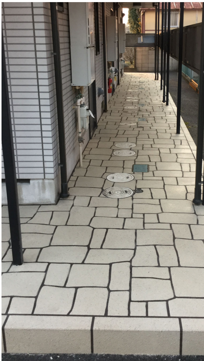
カットストーン（ストーングレー）、薄吹きベーススプレー（チャコール）
