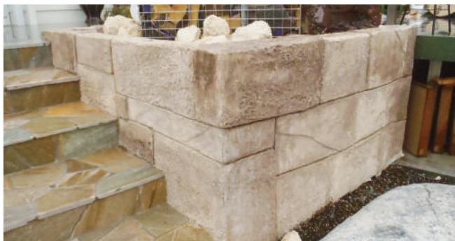
トラバーチン, 石積み施工
